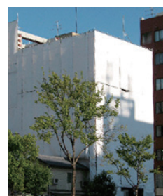
建築現場の養生シート
