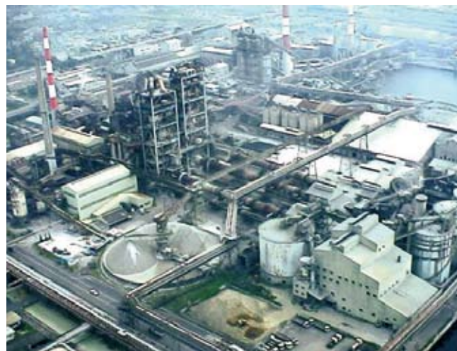
南陽事業所のセメントプラント
