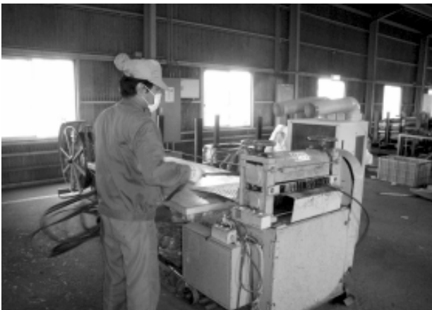
電線の解体作業風景
