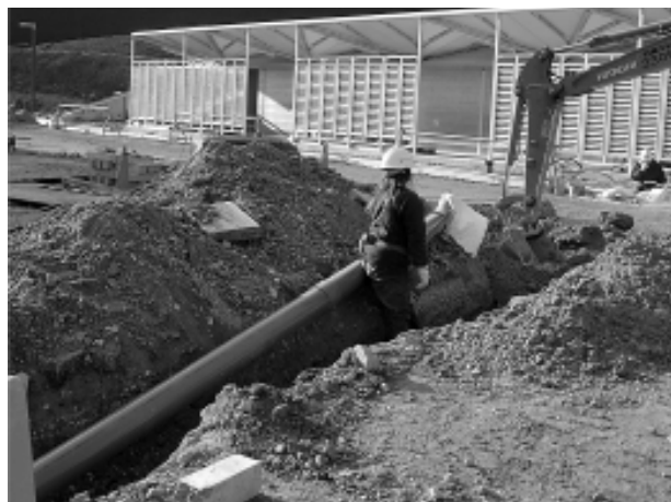
塩ビ管の施工作業風景
