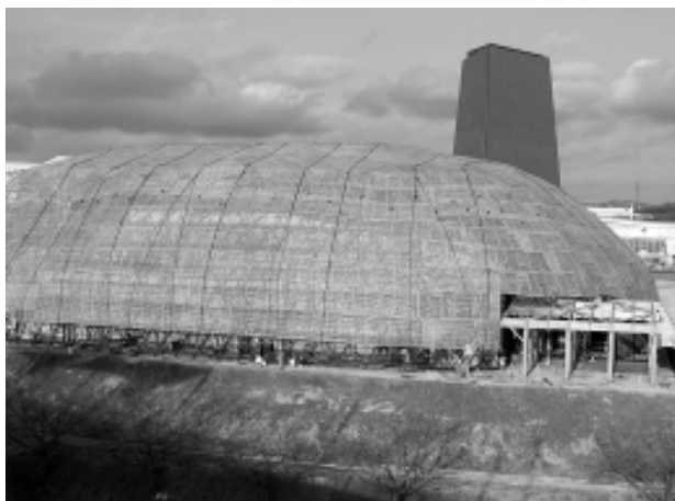
日本政府館の外観(2月時点では施工中)
