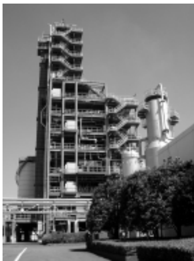
処理設備の全景
