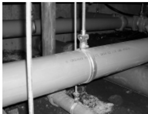
都営高井戸西一丁目アパートの施工状況(1階床下の横主管)
