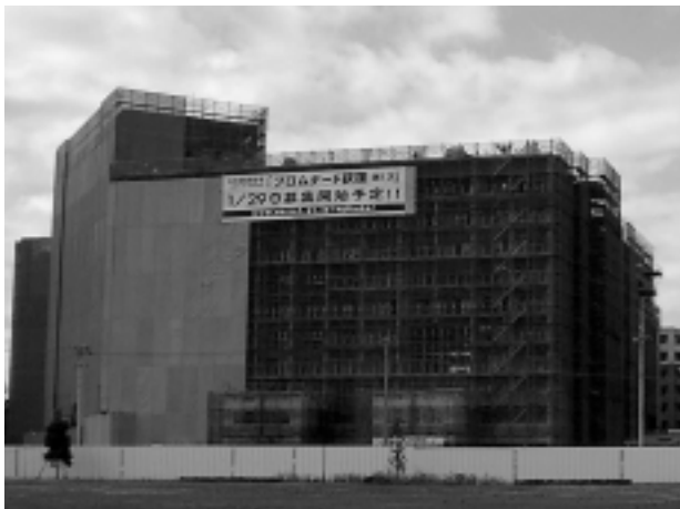
都市再生機構の賃貸住宅( 杉並区荻窪、建設中)
