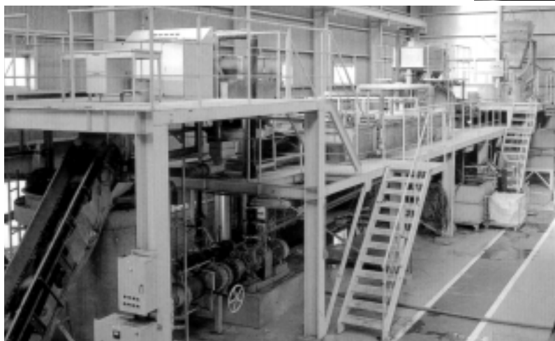
農業用廃ビニール再生装置プラント
