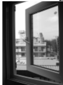
調布市に建設された外断熱マンション ◀塩ビサッシを使った窓
