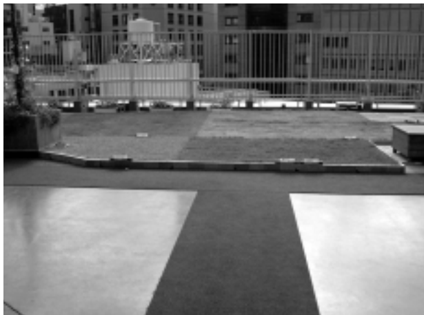
豊島区役所・屋上庭園の芝生ゾーン(緑石に塩ビ壁紙リサイクルブロック)
