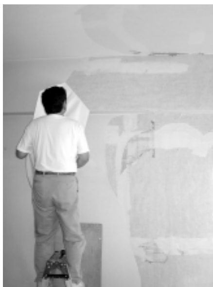
写真1：東京お台場の公団住宅改装工事の様様
