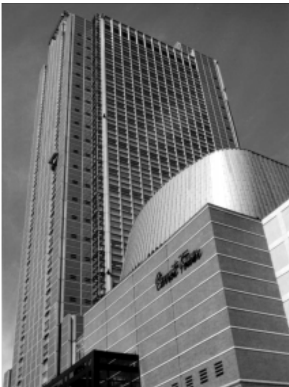
世田谷文化生活情報センター(キャロットタワー内)
