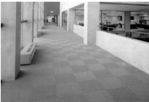
再生タイルカーペットの施工例
