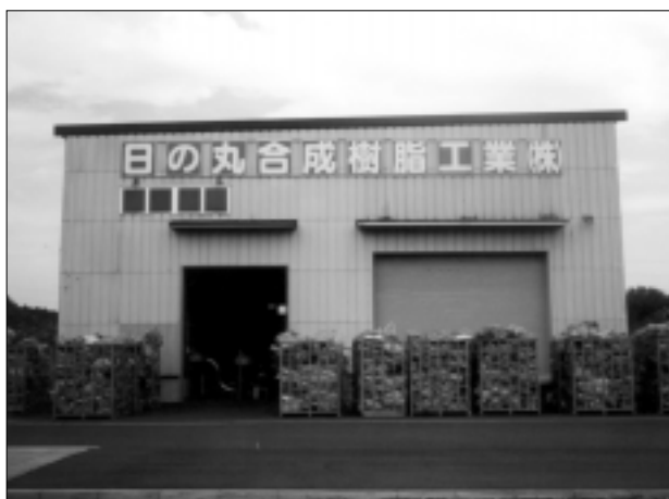
リサイクル・プラント全景
