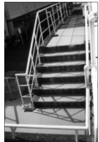
キャディー室の外階段に敷かれたハイキレスシート
