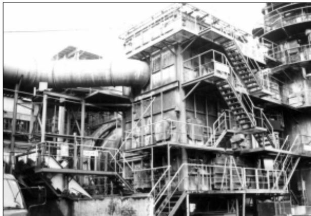
同和クリーンテックスの焼却設備
