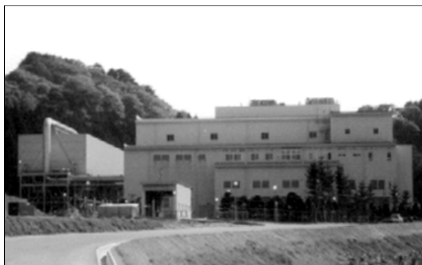
広大な青森 RER のサーマルリサイクルセンター (写真右側：ガス化溶融施設、左側：廃棄物受入施設)
