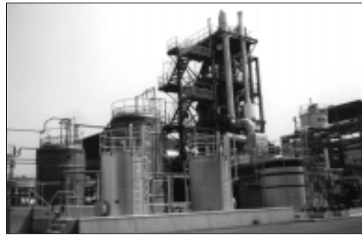
実証プラント全景
