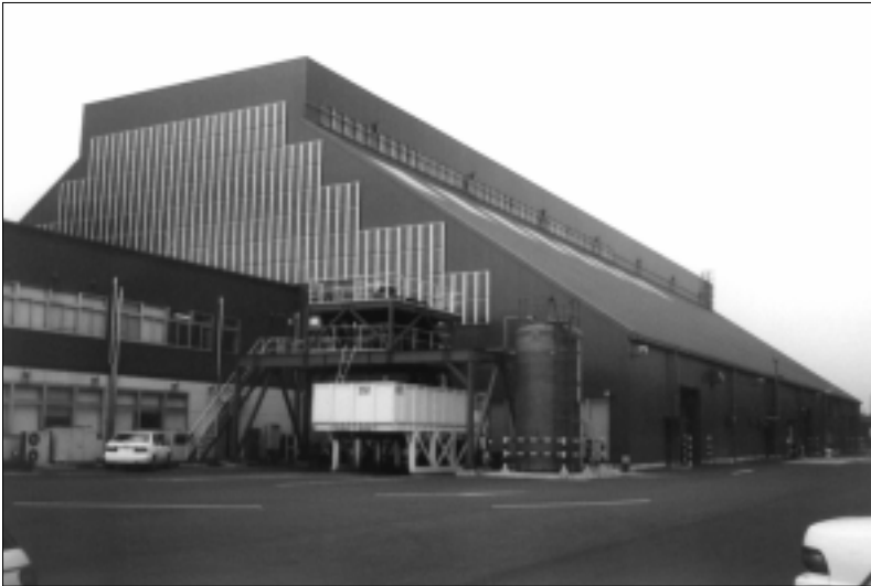
プラント外観（システムはすべて建物の中に収められています）
