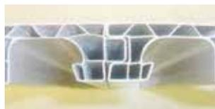
三角形を並べたトラス構造が、強度の維持、変形防止、防音性向上を実現。パネルの連結も、隙間を作らず、しっかり固定できる。
