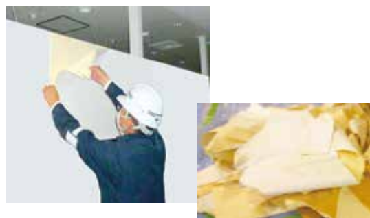
年間10万トン排出される塩ビ壁紙の施工端材
